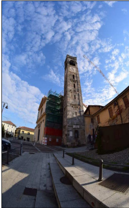
Figura 3.1 - La Chiesa di San Giovanni Evangelista con la torre campanaria di XI secolo.
