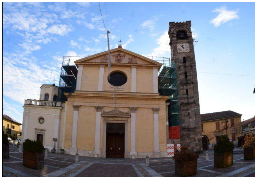
Figura 3.2 - Facciata della chiesa di San Giovanni Evangelista.
