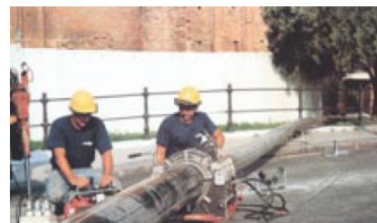
OPERAZIONI DI PIPE-COATING
